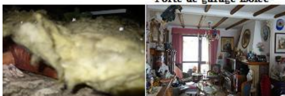
Isolation de la toiture
